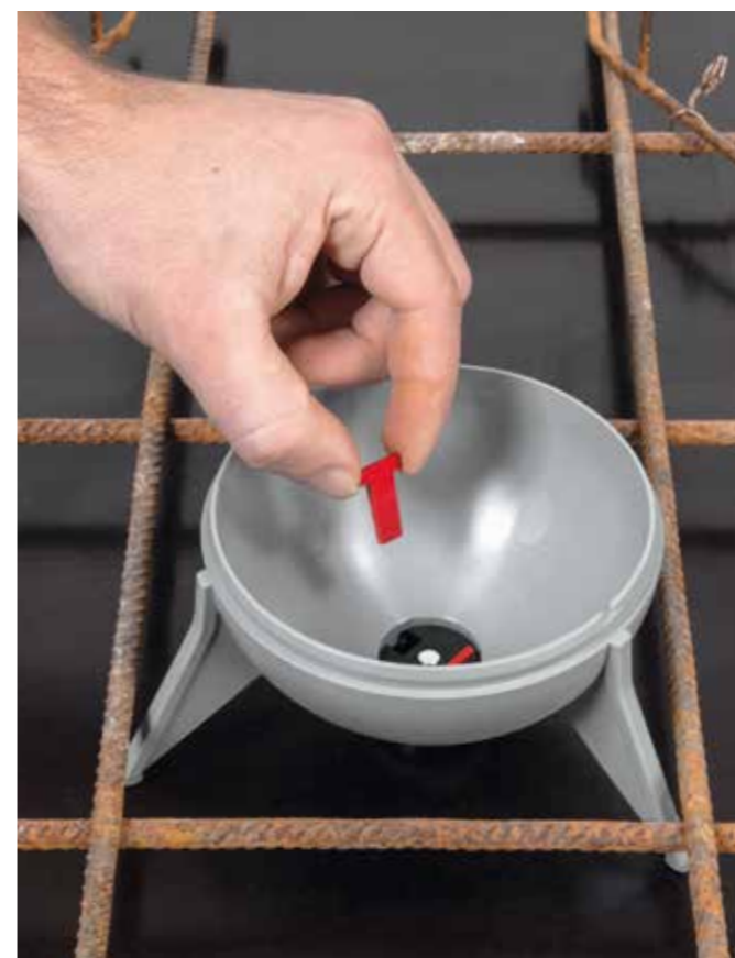
Der Sperrstift verhindern das Aufschwimmen der Kapsel.
